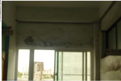
成功-土木測量系館
