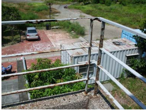
安南-環境資源研究管理中心實驗大樓
