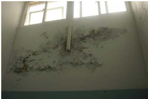
成功-土木測量系館
