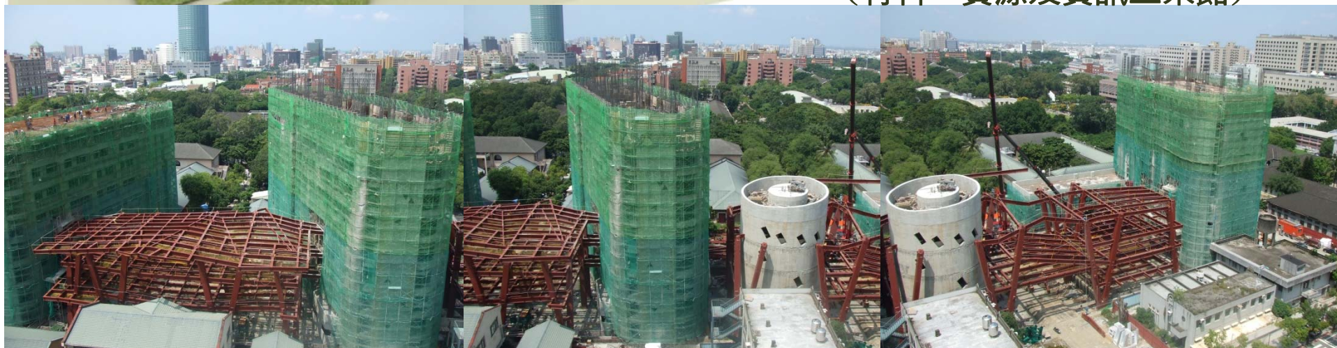
成功校區東側教學舍後期更新整建工程 (材料、資源及資訊三系館)
