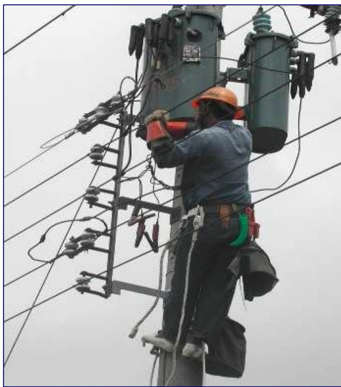
接近高壓架空電線場所使用絕緣防護具
