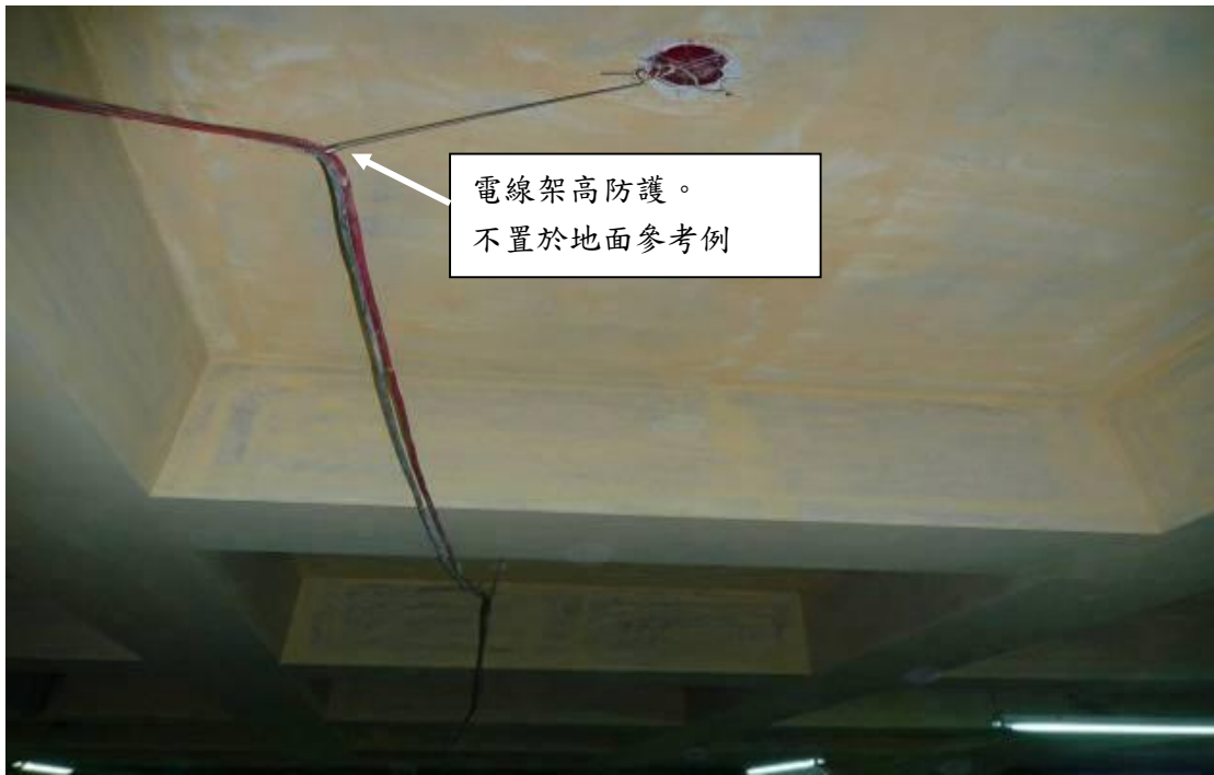
電線架高防護
