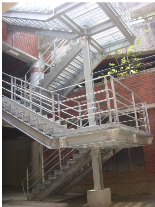
成功校區地下停車場
