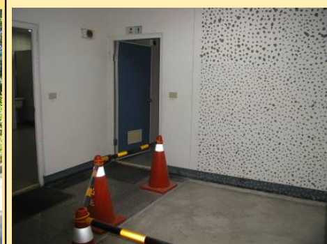
修齊大樓三樓廁所
