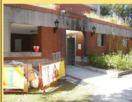
都計系館 東側外部廁所
