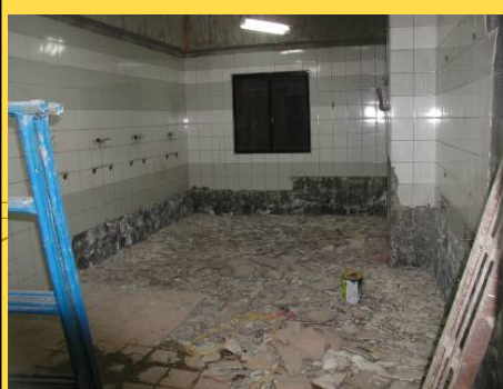
雲平大樓鳳凰劇場 旁廁所
