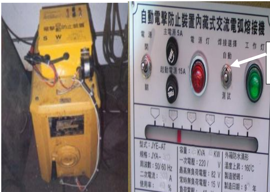
照片 4 交流電焊機自動電擊防止裝置參考例
