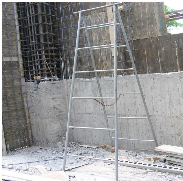
7、合梯以角材、木材片製成或以鐵管架組成，其兩梯腳間未能以堅固之繫材繫牢（使用鐵線、鐵鏈、電線、塑膠繩、布繩等）、未有安全之梯面，不符合規定之照片。
