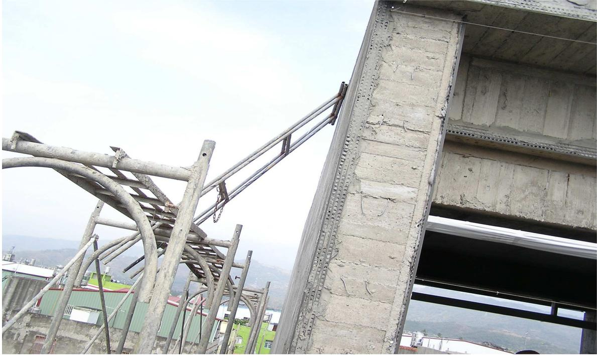
5、將移動梯、合梯置於施工架上使用，有墜落之虞不符合規定之照片。
