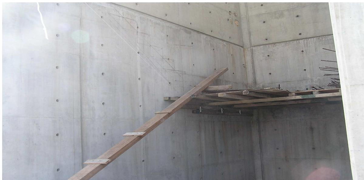
2、工地隨意取材製作移動梯，移動梯之梯柱寬度未達 30 公分，不符合規定照片。
