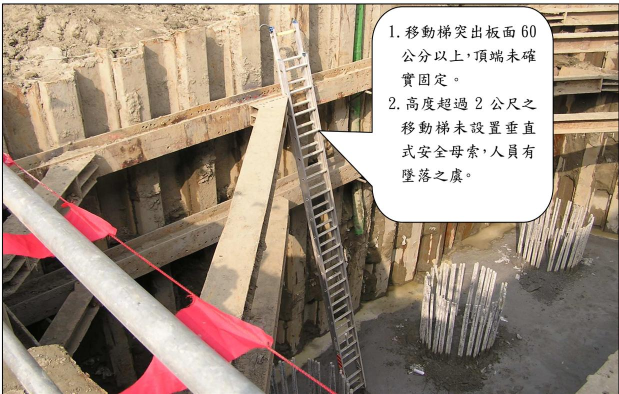
4、移動梯作為上下設備之用途時，梯子之頂端未突出板面 60 分以上，且未妥為確實固定，高度超過 2 公尺之移動梯未設置垂直式安全母索、未設置止滑防墜器、捲揚式防墜器供作業人員使用安全帶鉤掛，不符合規定之照片。
