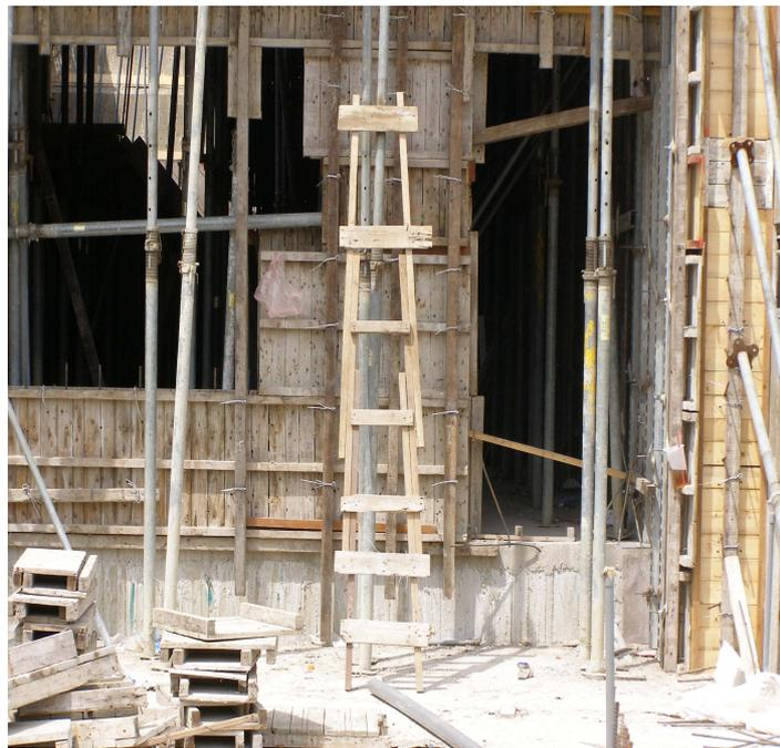
1、工地隨意取材製作移動梯，任意搭接梯柱，無法確認有堅實構造，不符合規定之照片。
